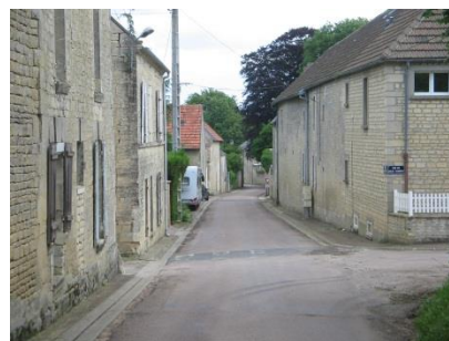
Alignement créé par un front bâti continu
