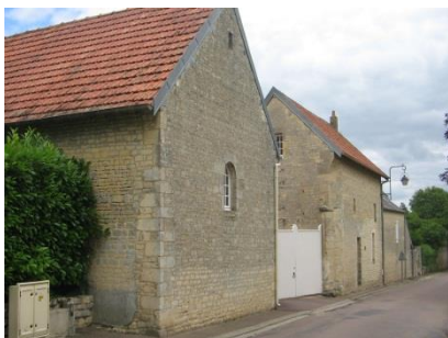
Alignement alternant pignon et façade
